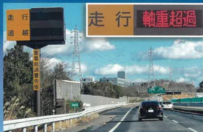
高速道路本線での「軸重超過」表示
